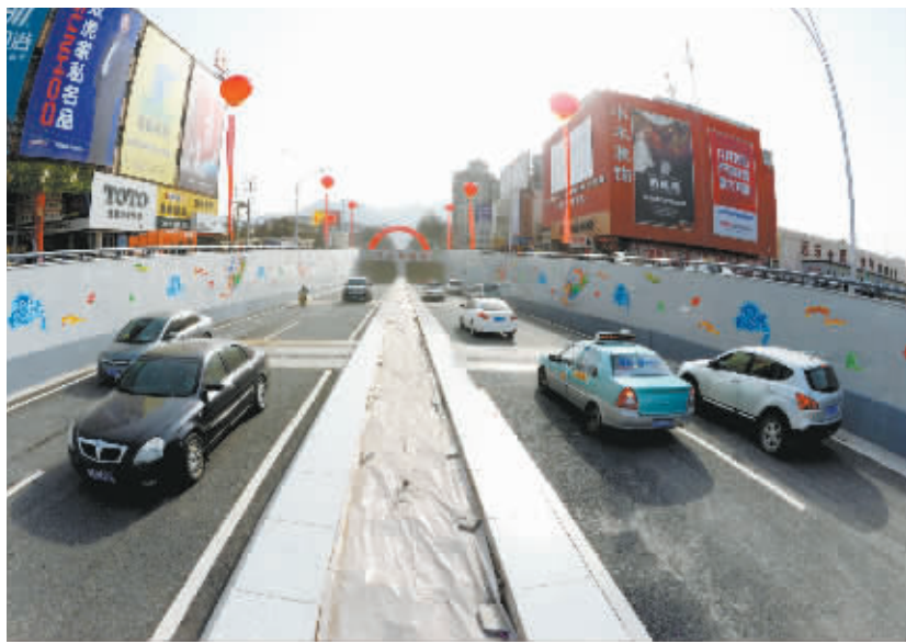
1月26日,兰州市首个下穿工程——天水路(宁卧庄)下穿读者大道道路改造工程正式通车。 本报首席记者 裴强 摄
