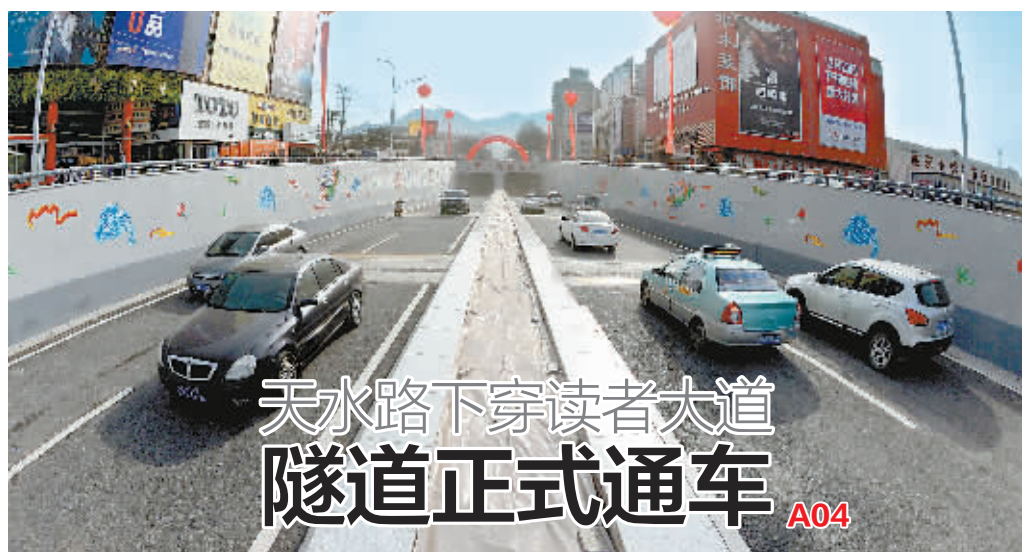
1月26日,兰州市首个下穿工程——天水路(宁卧庄)下穿读者大道道路改造工程通车。本报首席记者 裴强 摄
