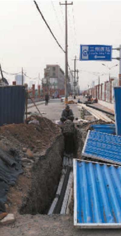
施工现场,路面被挖开,泥土裸露。
