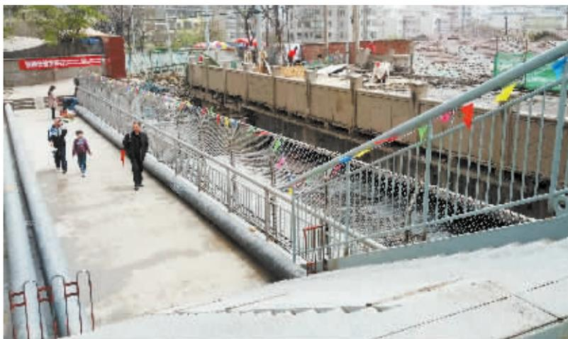
市政大坡桥即将拆除,施工单位在西侧搭建了一座钢便桥供行人通行。
