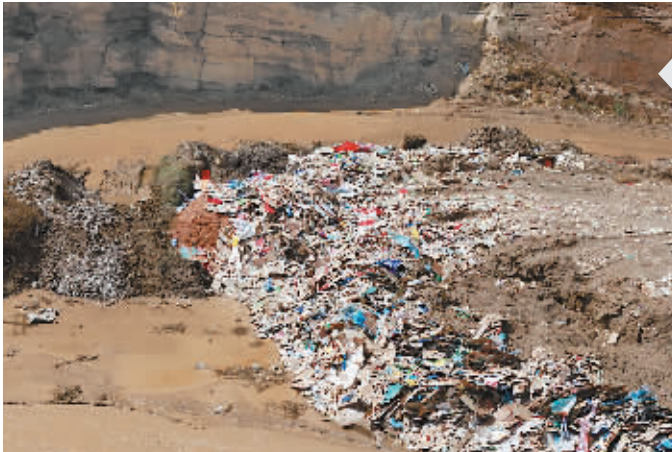
垃圾堵塞排洪沟。本报记者 党运 摄
