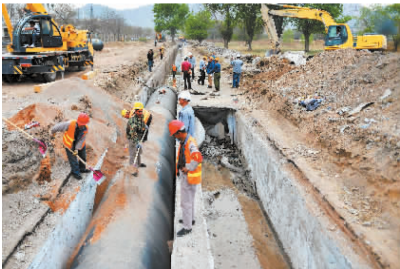
4月14日,施工人员进行输水管道敷设作业。新华社照片
