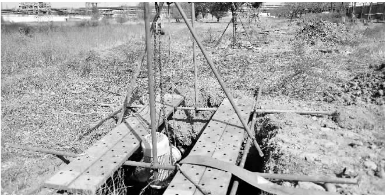
图为受污染自流沟的处置井。 新华社照片
