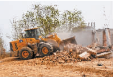
拆除现场。本报记者 田玥 通讯员 朱琳 摄
