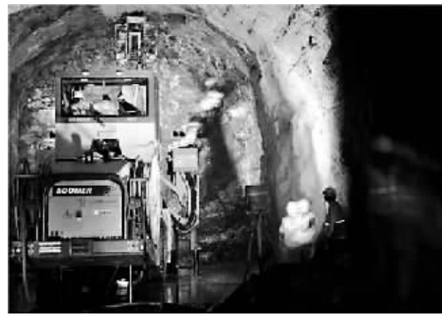
水电站施工现场。人民网照片
